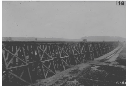
Ligne de chemin de fer Hesdin/ Frévent en 1918
