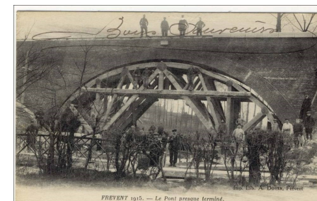
Pont du Marais presque terminé en 1915
